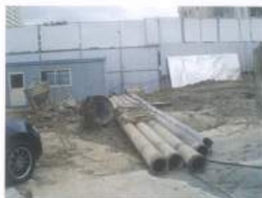
ท่อเทคอนกรีตได้น้ำ (Tremie pipe)
