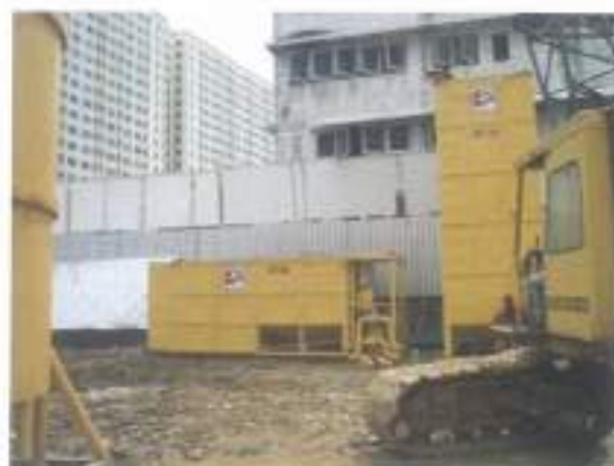
ถังผสมและเก็บน้ำยาเบนโทไนท์ / โพลีเมอร์
